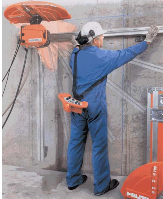
Σχήμα 2: Κοπή τοίχου με δισκοπρίονο επί τροχιών καθοδήγησης
