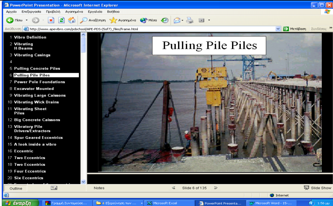
Σχήμα 1: Εξόλκυση μεταλλικών πασσάλων λιμενικού έργου με την χρήση δονητικού πασσαλοπήκτη/εξολκέα
